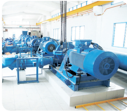
Kerja-kerja penggantian dan penyelenggaraan aset
