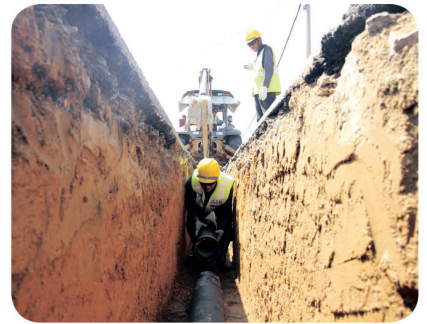
Kerja-kerja pembangunan dan menaiktaraf sistem agihan (termasuk penggantian paip usang sepanjang 438.49 kilometer)
