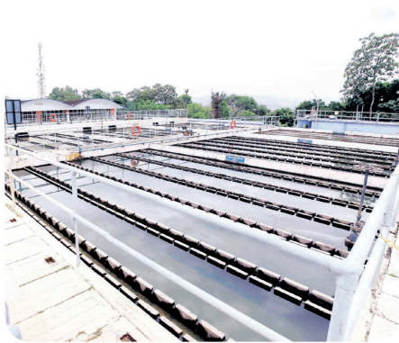
Kerja-kerja menaiktaraf loji rawatan air
